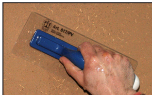
Étape 3 - à mi-séchage, resserrer l'enduit à l'aide d'une spatule plastique souple.
