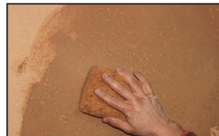
Étape 4 - une fois l'enduit sec, passage d'une éponge semi-humide afin de faire tomber les poussières de surface et faire ressortir la fibre de paille.
