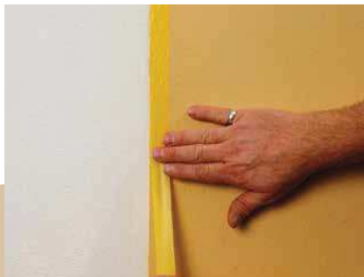
Pose d'un nouveau ruban adhésif après séchage
