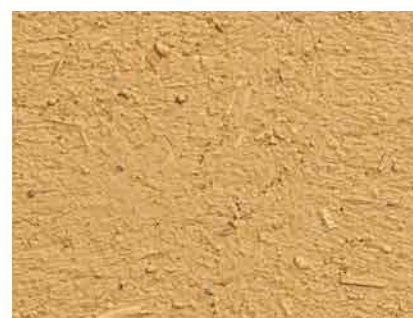
Structure d'une surface correctement préparée avec un primaire en argile
