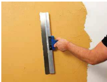
Talocher avec la spatule de surfaces
